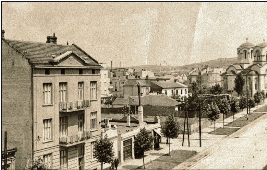
Изглед улице Цара Душана пре почетка изградње зграде Прве београдске гимназије 1936. године
